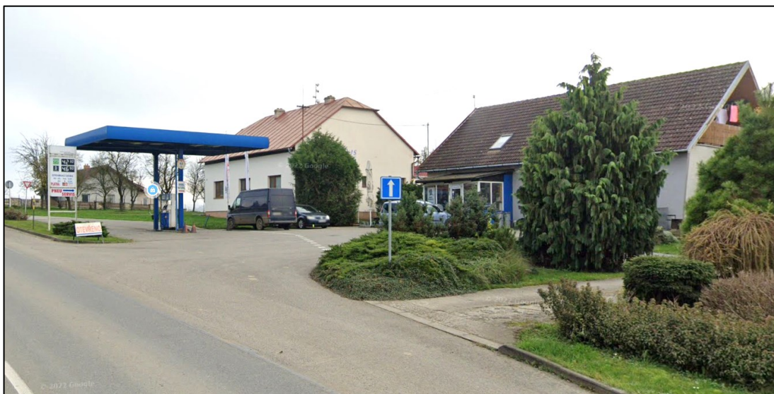
Obrázek 13 – Čerpací stanice (Google maps, 2023)
