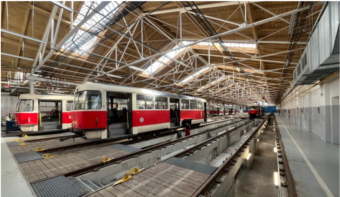
Obrázek 1: Vnitřní pohled na hlavní halu vozovny Strašnice (Vlastní zpracování)
