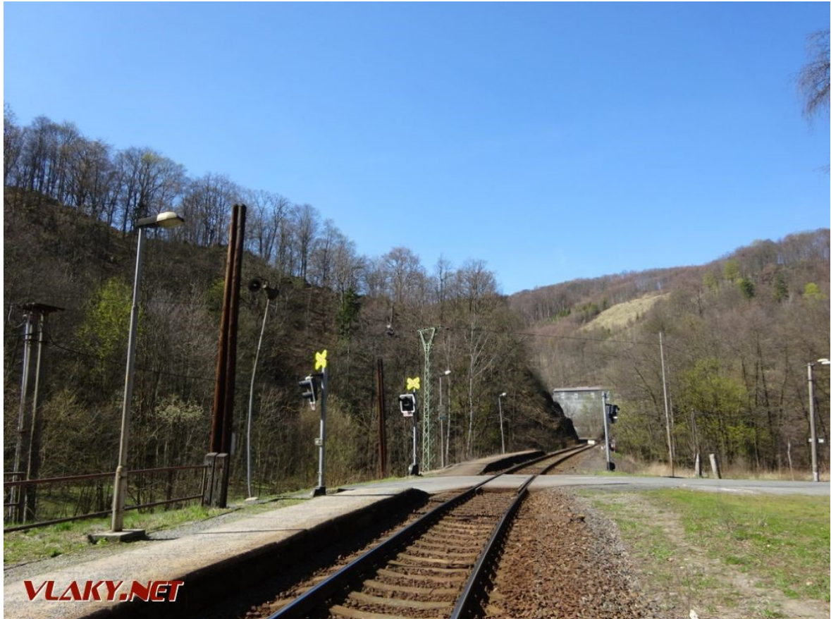
Obrázek 18 Hrubá voda – sklon svahu u železniční stanice a podél železniční trati [21]
