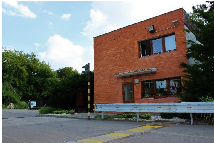
Obrázek 7 Přejezdová váha a administrativní budova (Vlastní zdroj)
