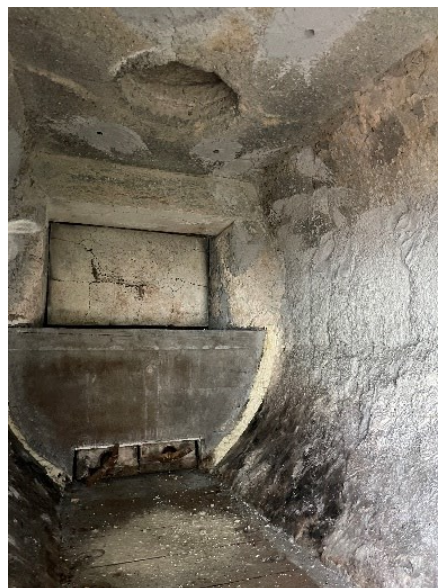
Obrázek 20 Šamotová vyzdívka komory pece (Vlastní zdroj)
