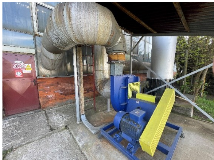
Obrázek 31 Spalinový ventilátor (Vlastní zdroj)
