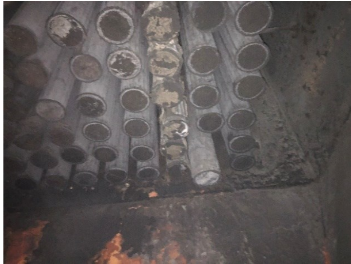
Obrázek 29 Jednotlivé tkaninové filtry uvnitř zařízení (Vlastní zdroj)
