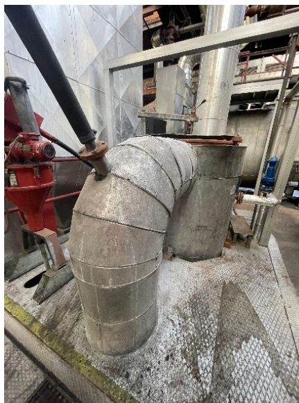
Obrázek 27 Místo vstříkování \text{CaO} (Vlastní zdroj)
