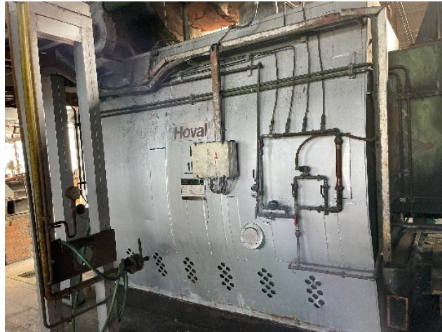
Obrázek 18 Pyrolýzní pec Hoval GG24 (Vlastní zdroj)
