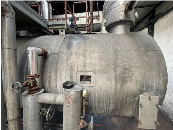
Obrázek 25 Výměník tepla (Vlastní zdroj)
