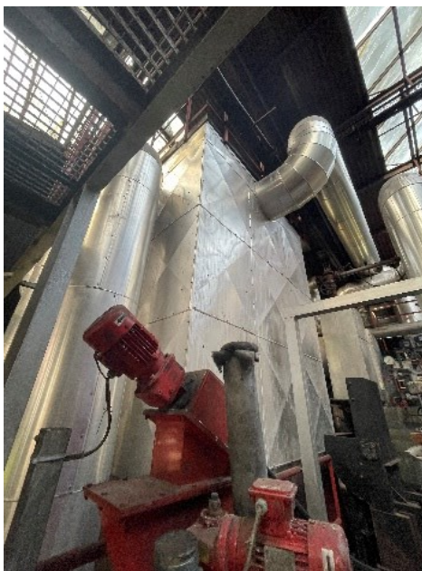
Obrázek 28 Spalínová pračka zvenku (Vlastní zdroj)
