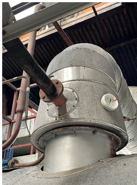
Obrázek 26 Místo vstříkování \text{NaHCO}_3 (Vlastní zdroj)
