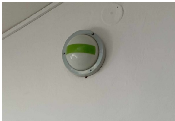
Obrázok 9 Núdzové osvetlenie
