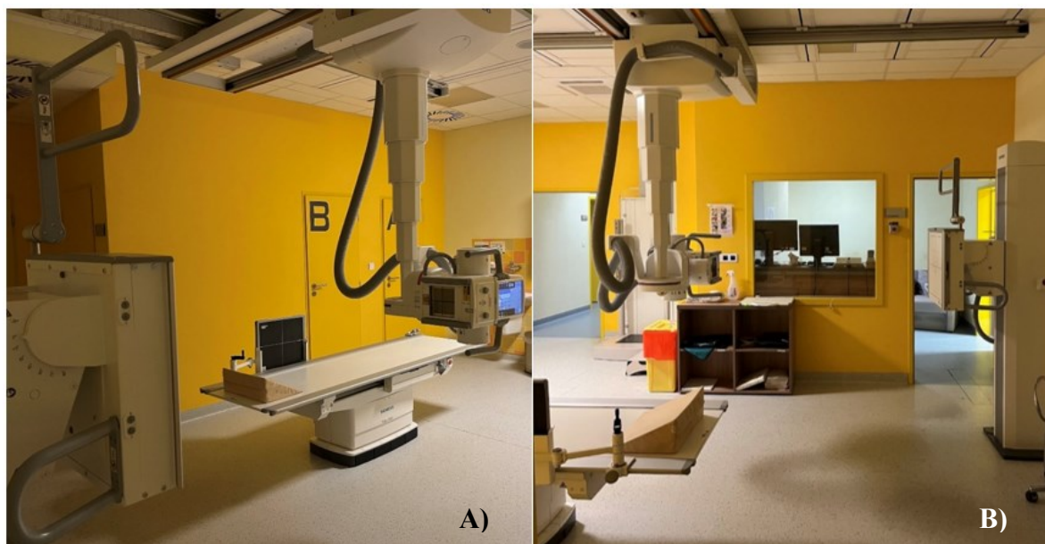
Obrázek 15 Snímkovna č. 1 – A) Pohled ze dveří ovladovny; B) Pohled na ovladovnu
