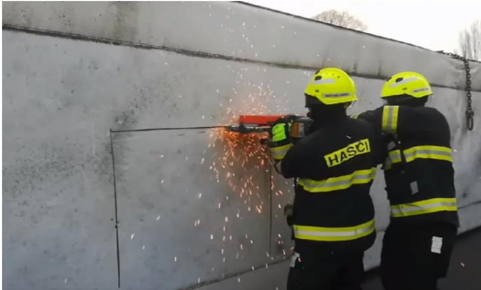
Obrázek 29 Vytvoření otvoru ve střeše (zdroj HZS Ústeckého kraje)
