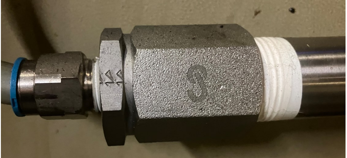
Obrázek 28 Detail zapojení měřícího přístroje IFM SD8500
