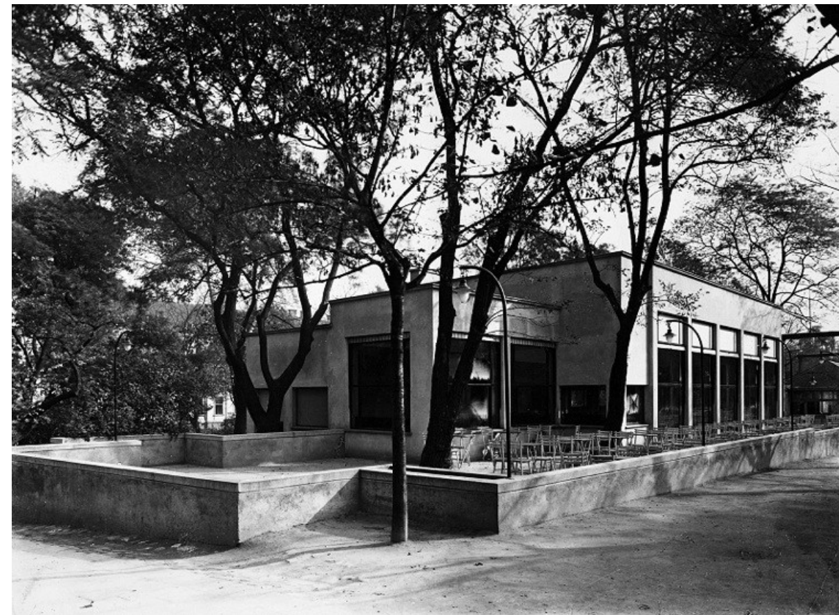
Obrázek 10: Zemanova kavárna (Jezuitská 687/6)[14]
