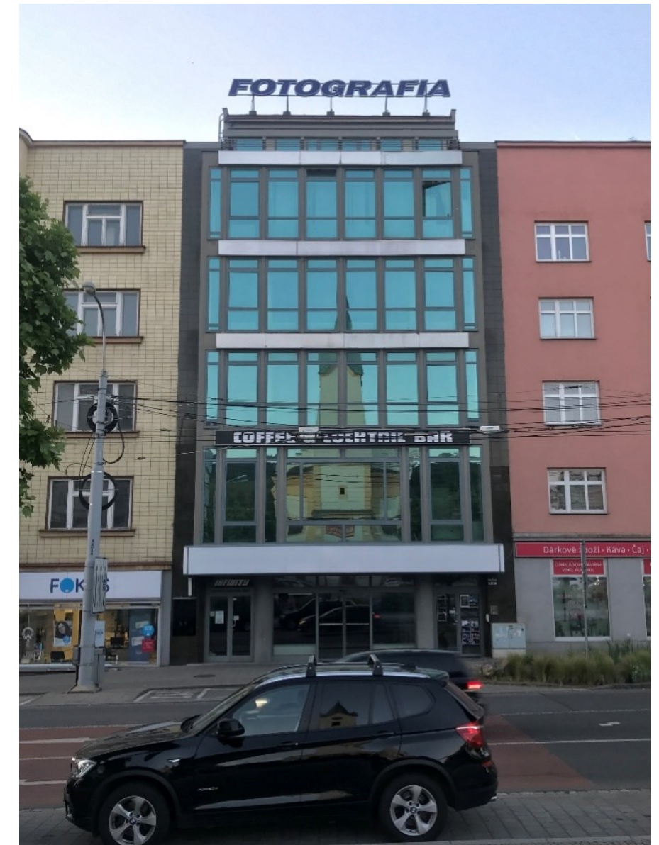
Obrázek 2: Současný stav budovy
