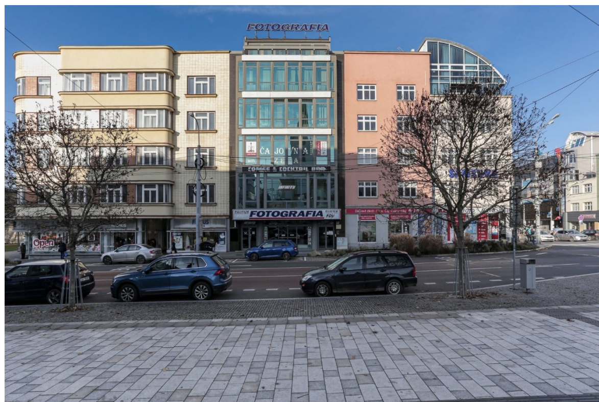
Obrázek 6: Fotografia – současný pohled [6]
