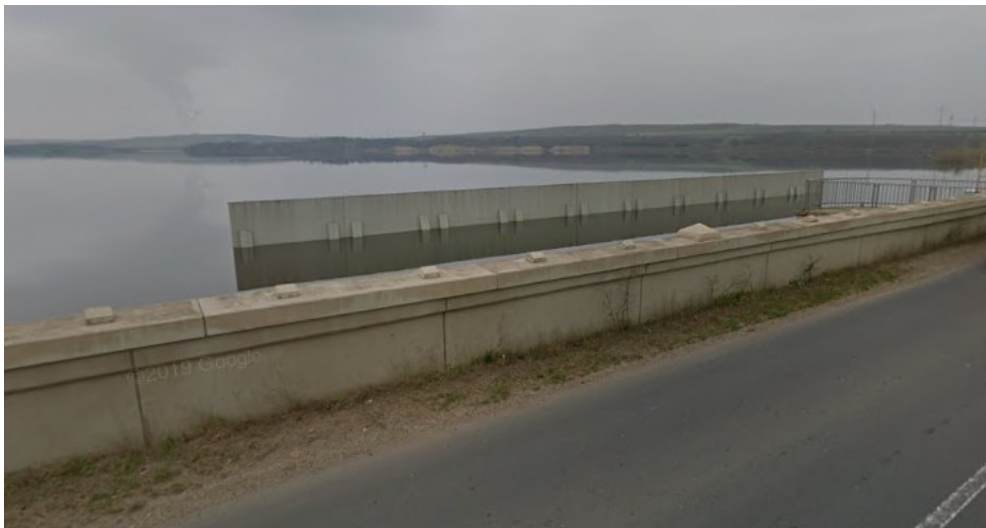
Obrázek 6 Vlnolam před přelivem nádrže Nechranice (vlastní, 2024)
