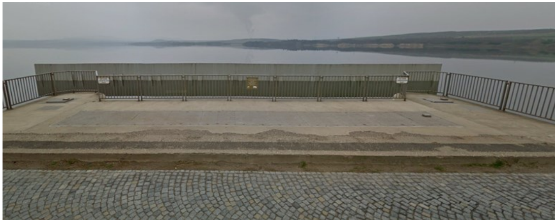
Obrázek 10 Dopravní komunikace na koruně přelivového objektu (vlastní, 2024)
