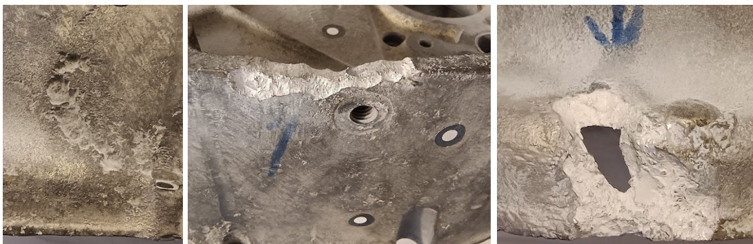
Obrázek 62 Vady způsobené korozí
