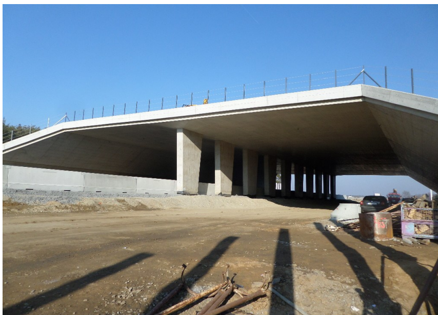
Obrázek 4 Stavba ekomostu přes dálnici
