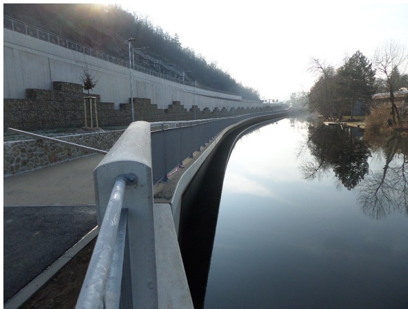
Obrázek 6 Opěrná zeď galerie od řeky Svatky
