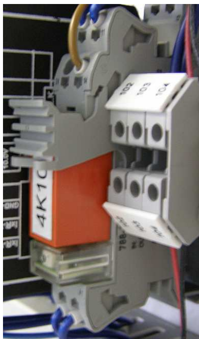
Obrázek 27 – Ochranný obvod proti přetečení nádrží
