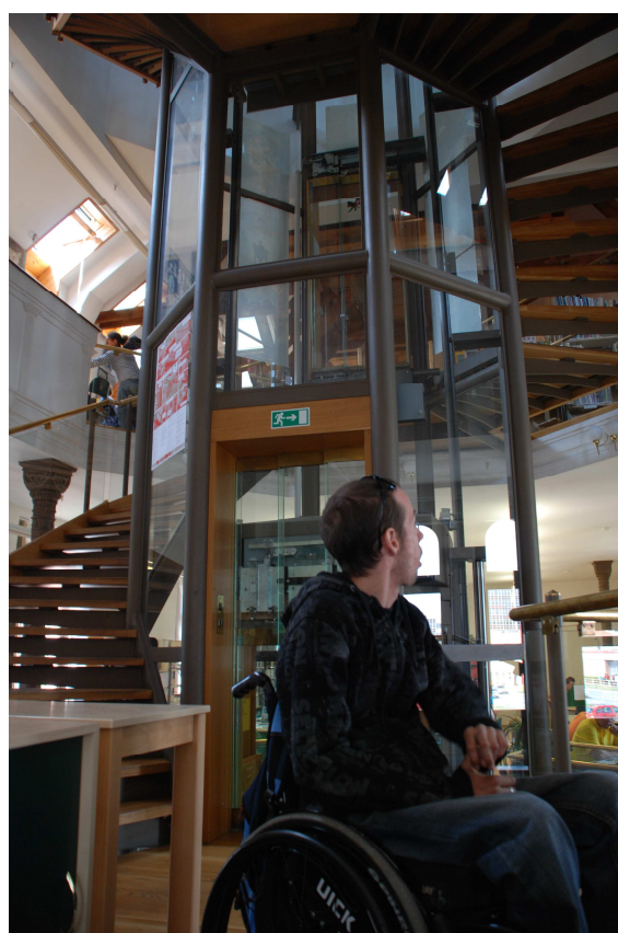
Obrázek č. 2 – Vnitřní výtah – knihovna Uherské Hradiště
