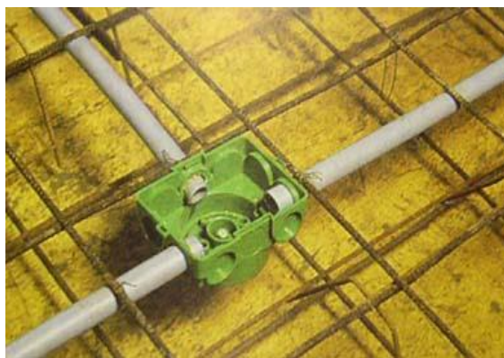
Obr. č. 3: Uložení kabelů do panelů
