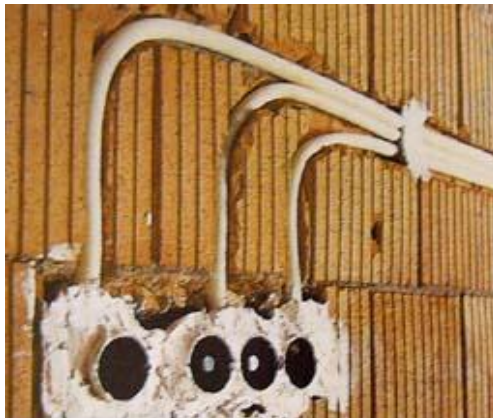
Obr. č. 4: Uložení kabelů pod omítku
