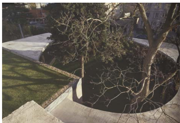
37/ pohled na betonovou desku domu EggO
