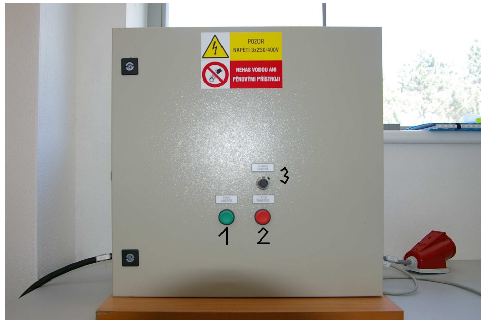
Obr. 21 Skriňa frekvenčného meniča
