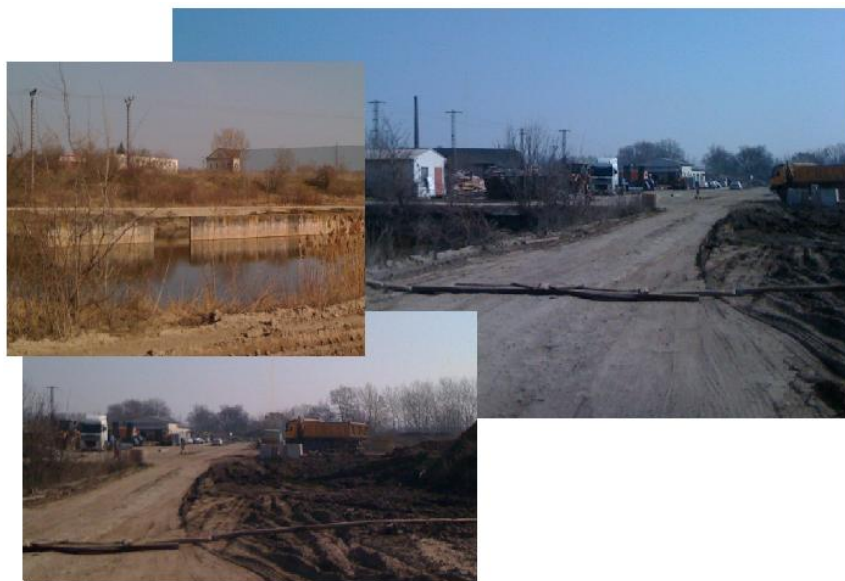
Obr. 9 Areál společnosti [vlastní zpracování]
