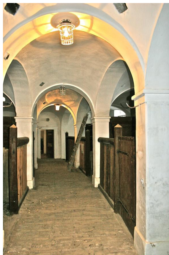
Obr. 36. Pohled do prostoru konírny.
