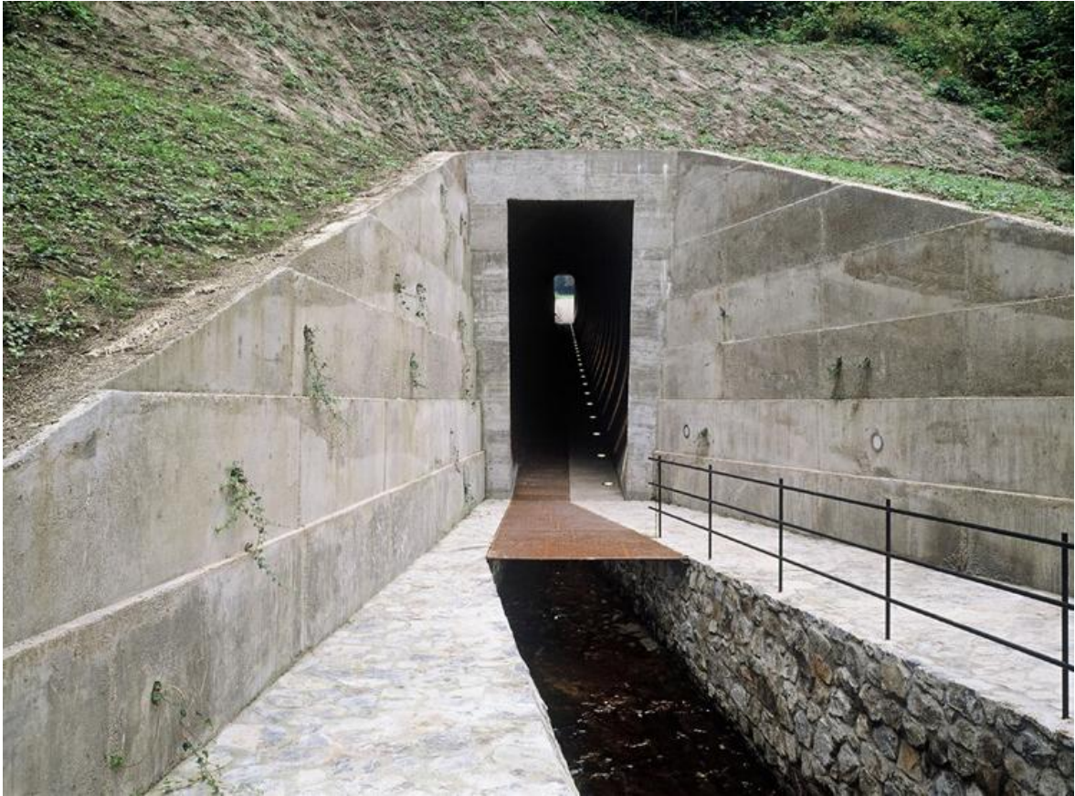
Obr. 58. Vstupní prostor průchodu.
