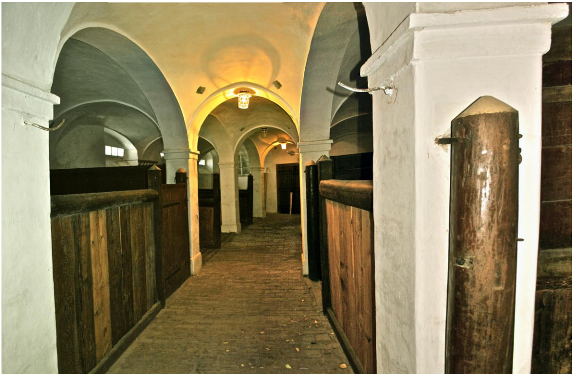
Obr. 27. Pohled z centrální chodby konírny.
