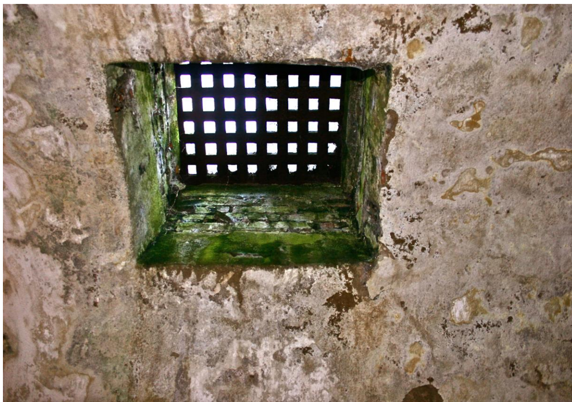
Obr. 34. Odvětrávací systém výjezdového tunelu.
