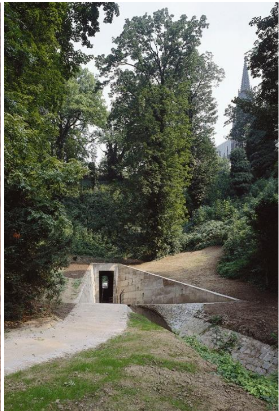
Obr. 60. Pohled na vstupní prostor průchodu.
