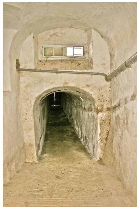
Obr. 33. Okenní výklenek nad výjezdem.
