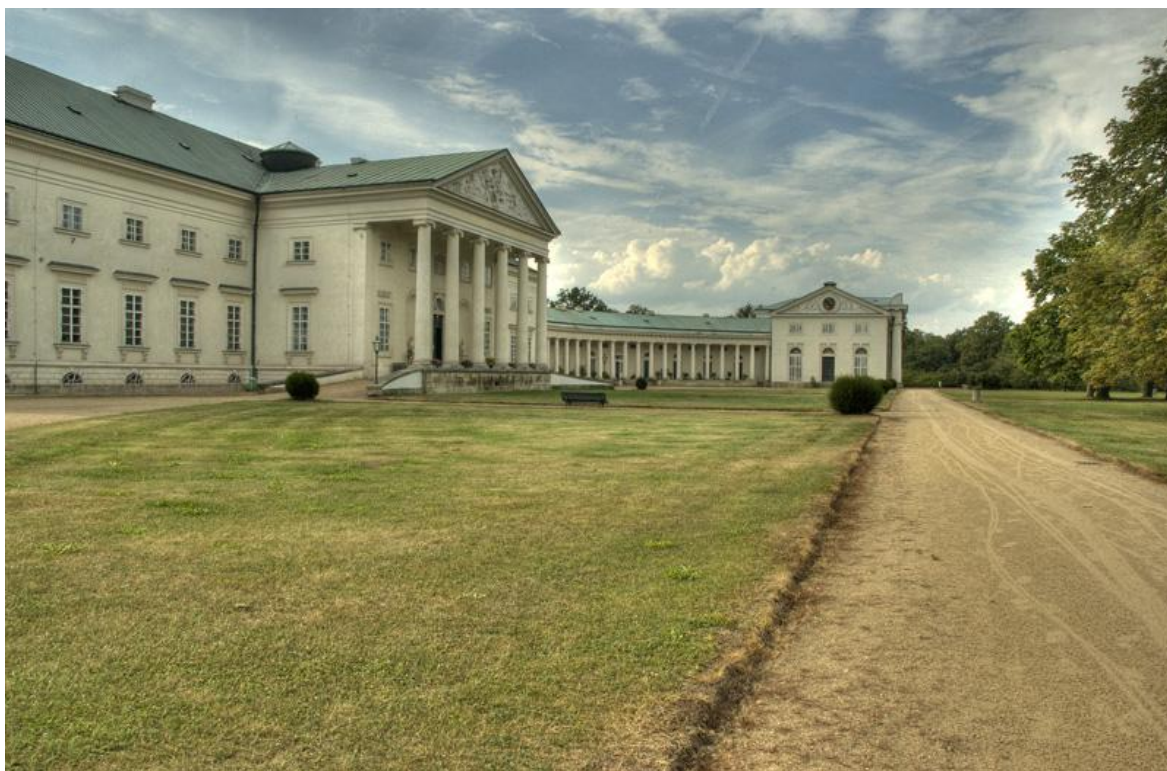
Obr. 7. Pohled na pravý boční pavilon s divadlem a kaplí.
