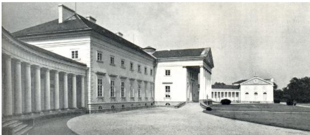
Obr. 15. Pohled na vstupní průčelí hlavního sálu.
