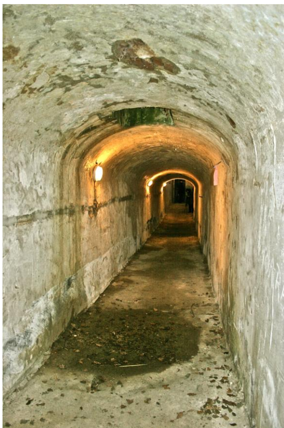
Obr. 30. Pohled do výjezdového tunelu.
