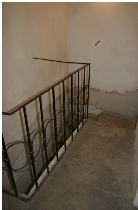
Obr. 46. Schodiště do patra pravé kolonády.
