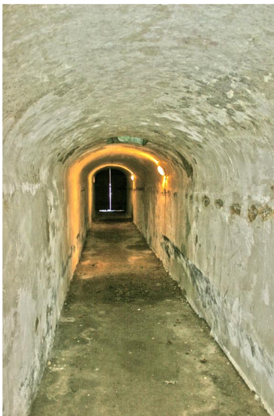
Obr. 32. Pohled na výjezd z tunel.
