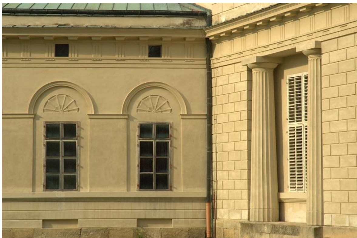
Obr. 11. Pohled na propojení pravé kolonády s pravých pavilonem.
