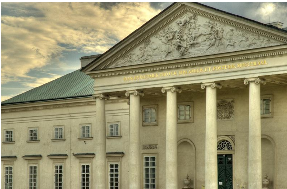
Obr. 9. Pohled na detail vlysu hlavního portiku.
