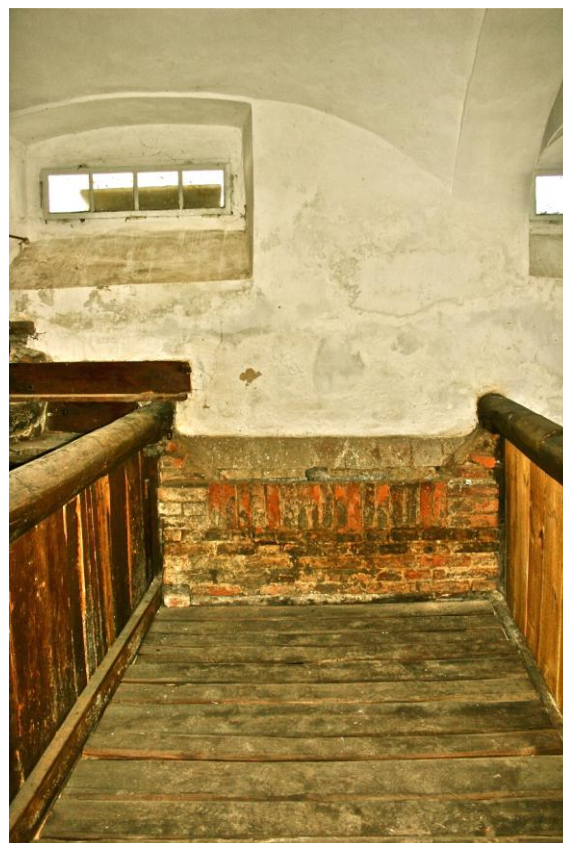
Obr. 40. Žlab zhotovený z cihel.
