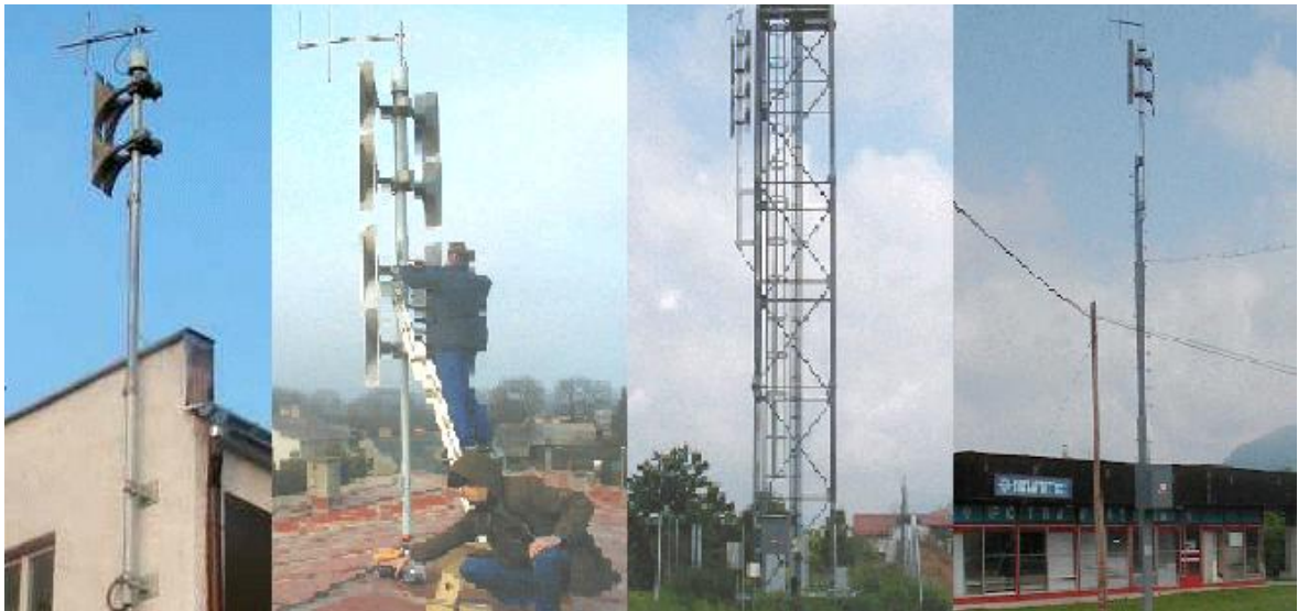
Obr. 10. Způsoby montáže sirény
