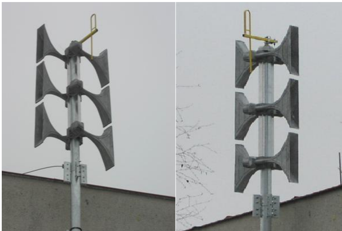
Obr. 6. Elektronická poplachová siréna
