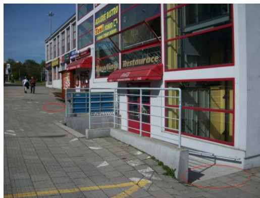
obr. 8 dva bezbariérové vchody
