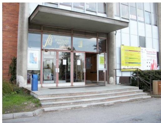
obr. 12 schody před vstupem do Domu umění
