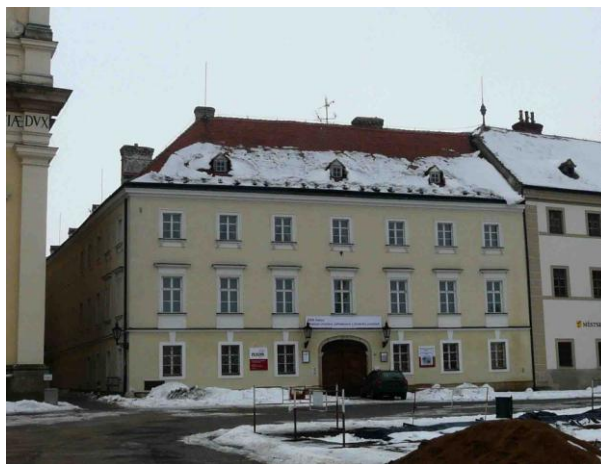
Obr. 2 Budova NZM Valtice
