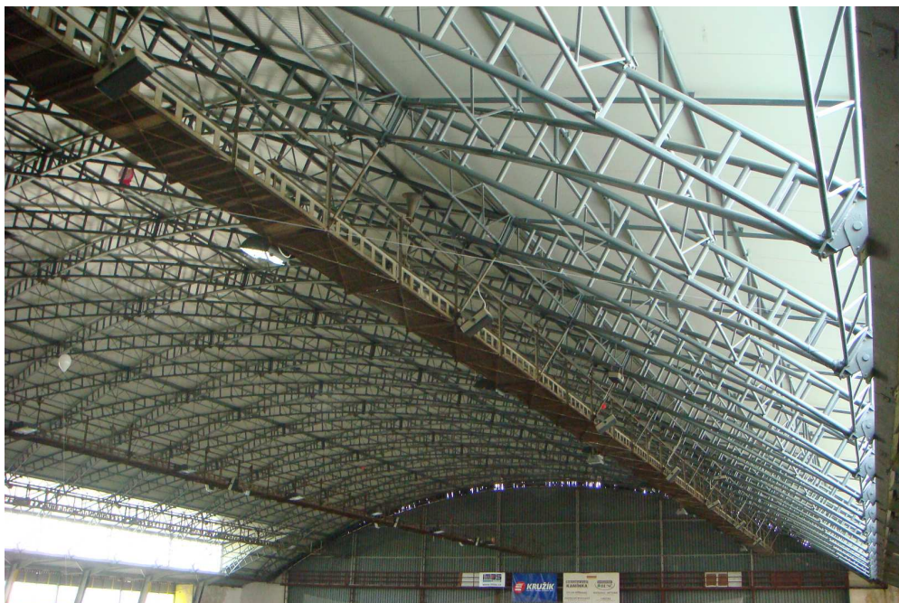
Foto 2 Konstrukce stropu haly
