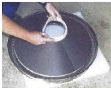
9) Navlékněte vnitřní těsnění na přírubu vložky a pevně přitlačte, aby byla černá látka upnutá
