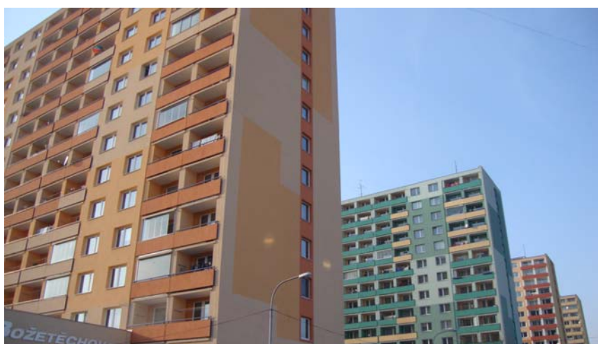
Soubor vybraných panelových domů na ulici Božetěchova v Brně.
