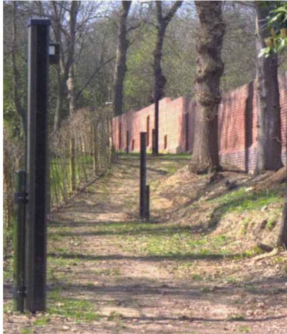
Obr. 5 Příklad použití IR závor. [12]
