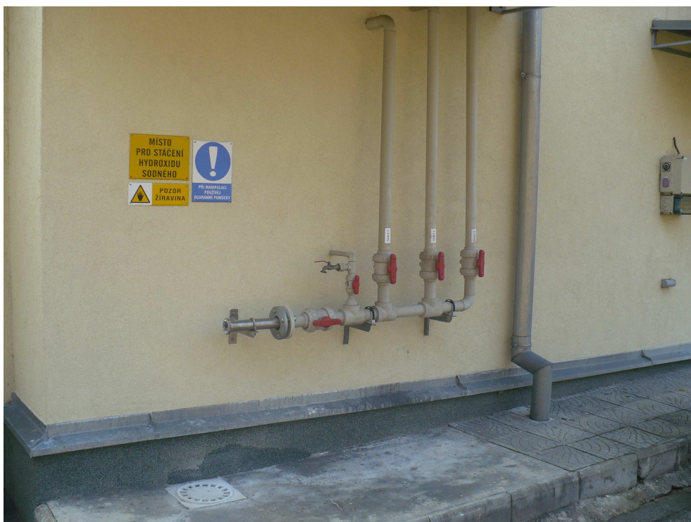
Obr. č. 15: Místo stáčení chemických přípravku z cisterny
