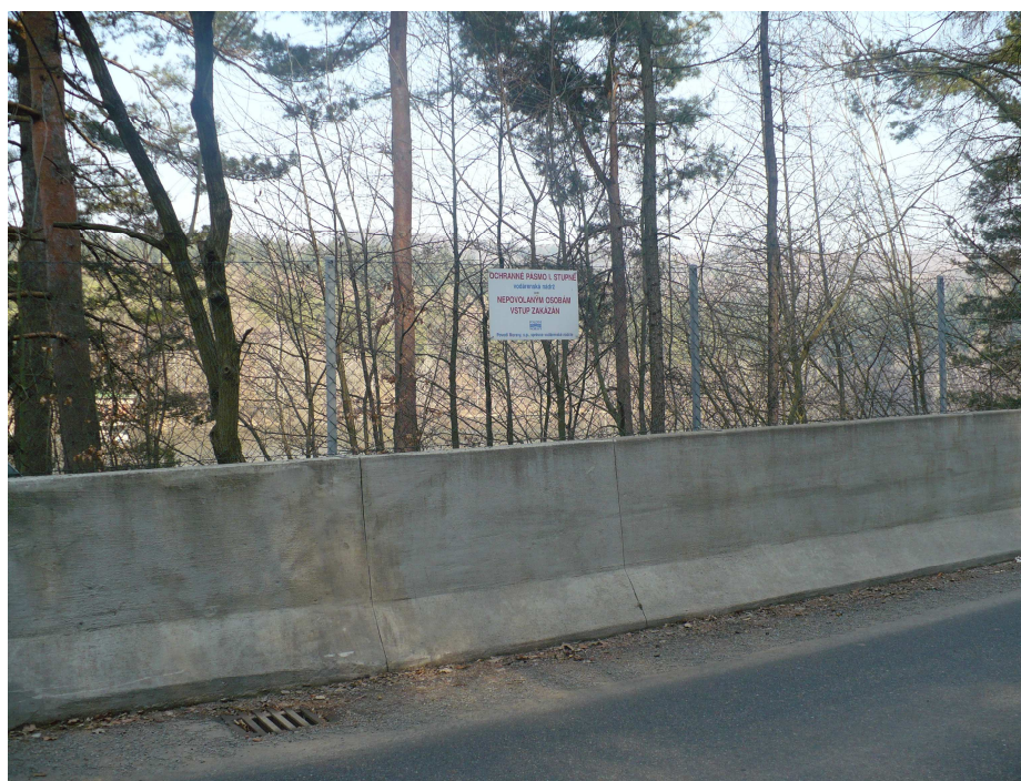
Obr. č. 4: Oplocení vodárenské nádrže s vyznačením ochranného pásma
