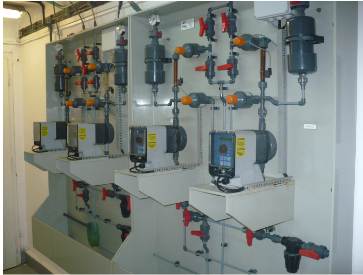
Obr. č. 6: Zdvojení systémů a čerpadel
