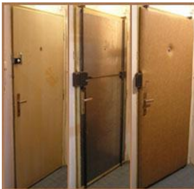
Obr. 37. Montáž přídatných bezpečnostních dveří.
