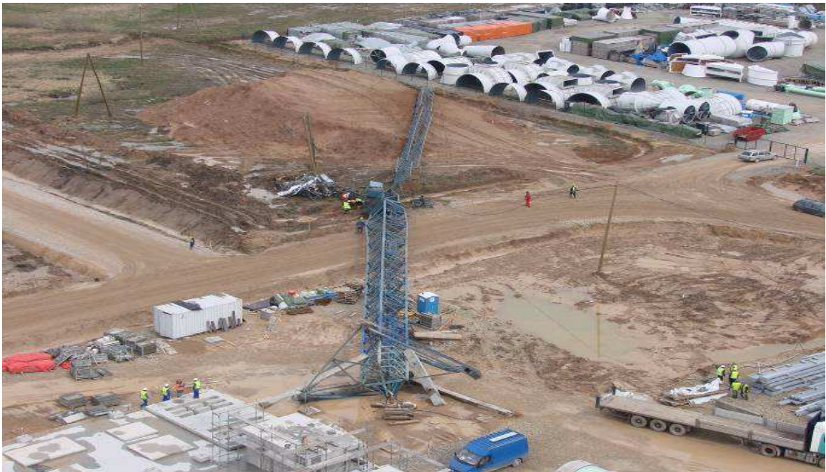
Obrázek 4 Havárie jeřábu při stavbě vysoké pece v Mexiku [Zdroj interní]
