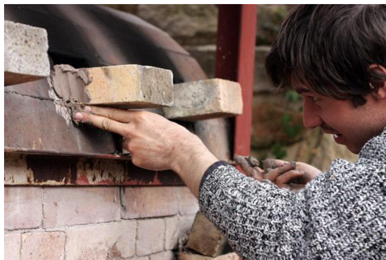
Obr. 87. Zamazání všech otvorů pece.
