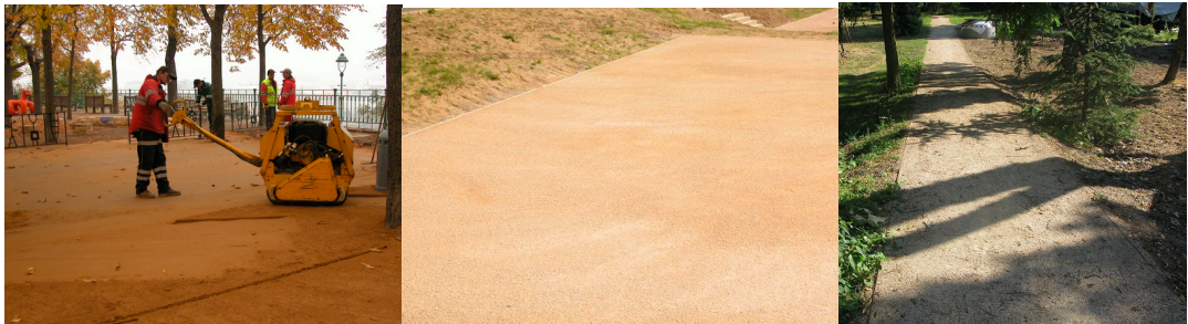
Obr. 23 Mlatový povrch založený technológiou MSK
