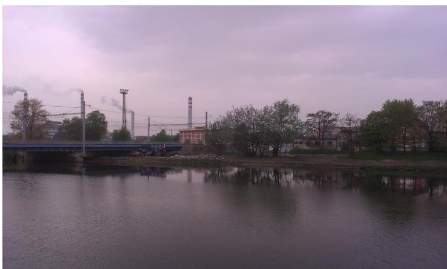
Obr. 22. Nevhodně tvarované koryto před železničním mostem [vlastní]
