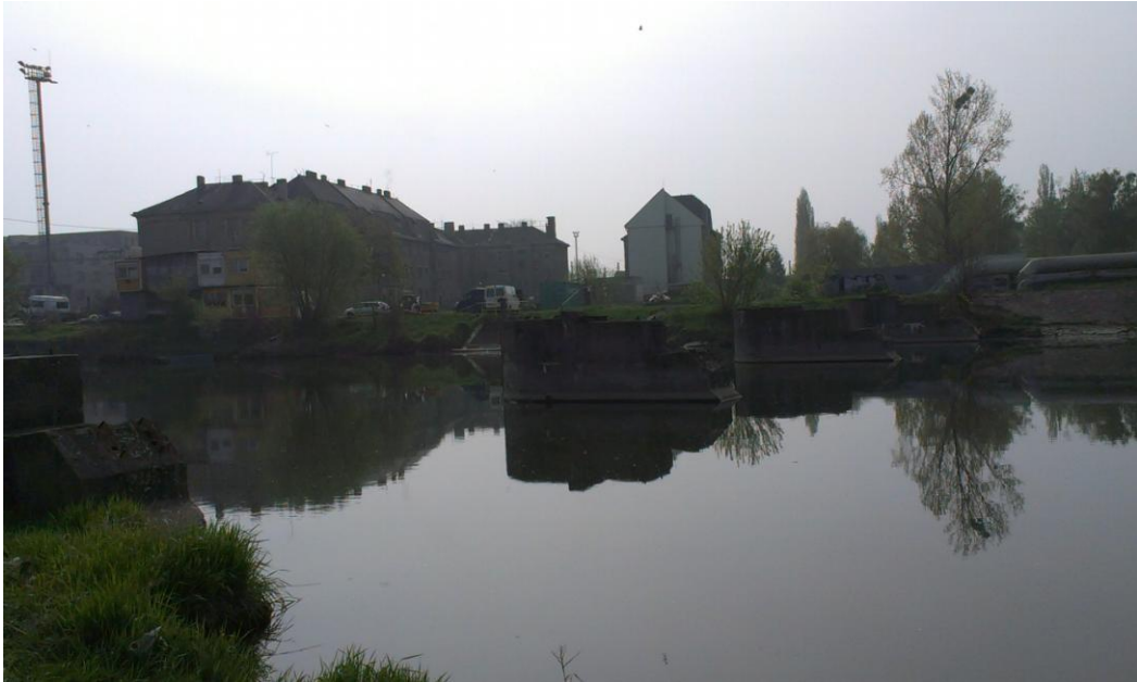
Obr. 16. Pilíře zbouraného jezu [vlastní]
