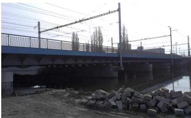
Obr. 14. Železniční most [vlastní]
