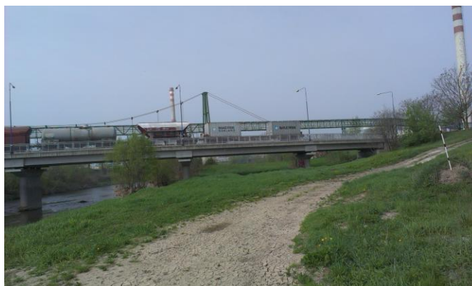
Obr. 15. Most železniční vlečky Prechezy a.s. [vlastní]
