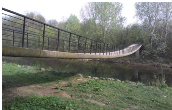
Obr. 10. Pohled na lávku z pravé strany [vlastní]
