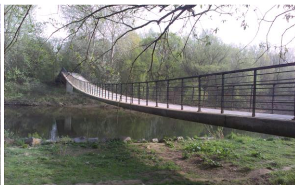
Obr. 11. Pohled na lávku z levé strany [vlastní]
