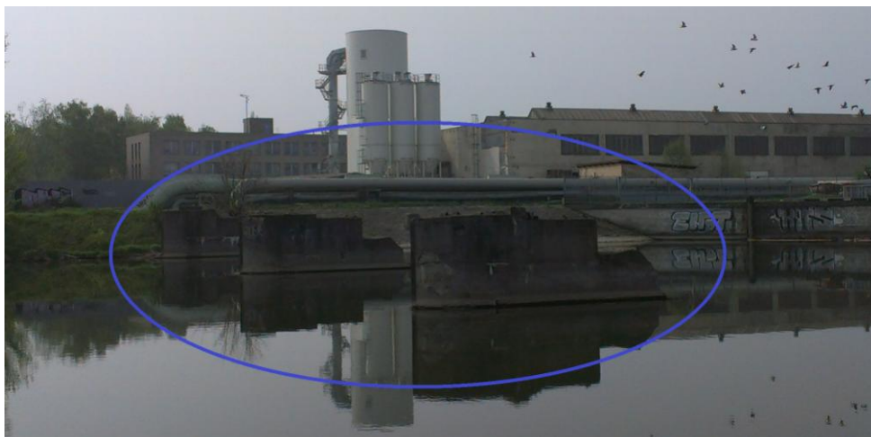
Obr. 25. Pilíře starého jezu v korytě řeky Bečvy [vlastní]
