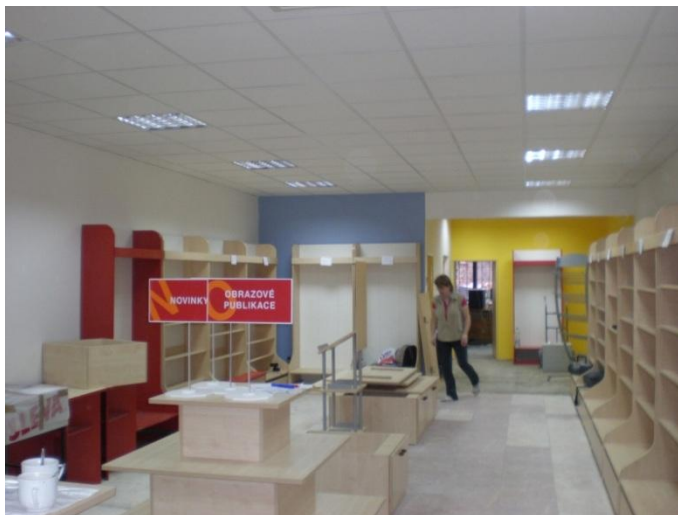
Obr. 9 Instalace nábytku v knihkupectví Euromedia
