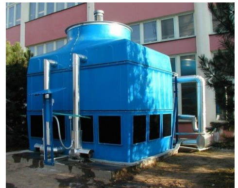
Obr.28 Skrápěná chladicí věž
