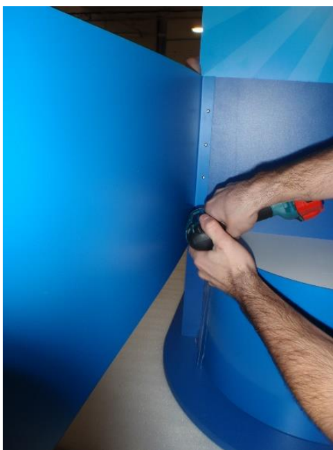
Obr. 22. Montáž hrabáku (vlastní zpracování)
