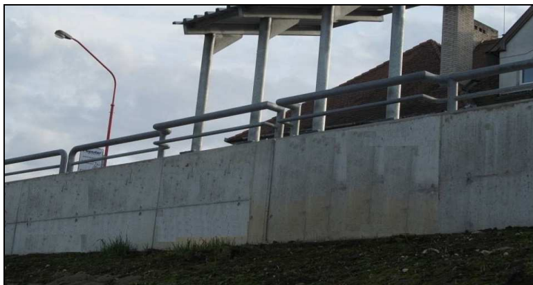
Obr. 6 Železobetonová zeď na Moravním nábřeží UH. [25]
