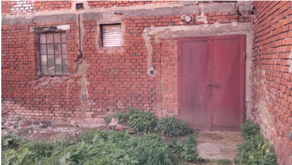
Obr. 7 Boční vchodové dveře [Zdroj: vlastní]
