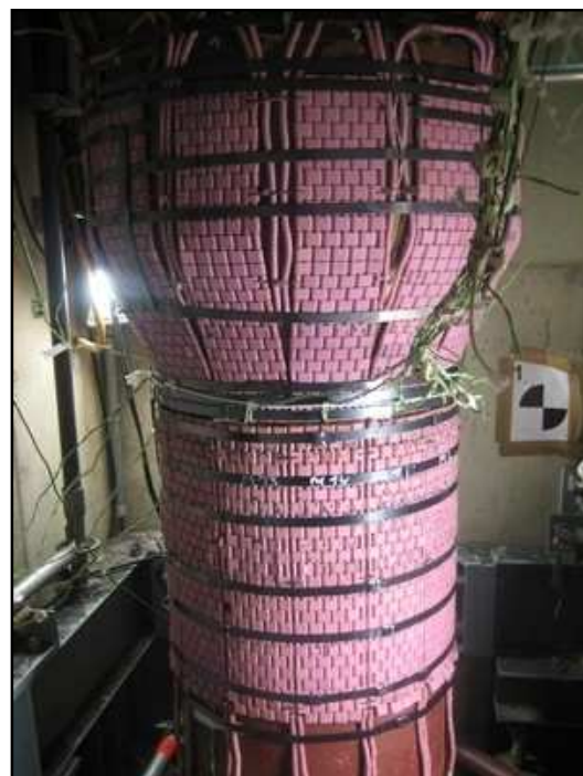
Obrázek 9- Žihání elektrickým odporem
