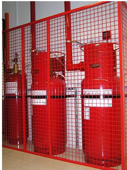
Obr. 26. Plynové SHZ FM200[14].
