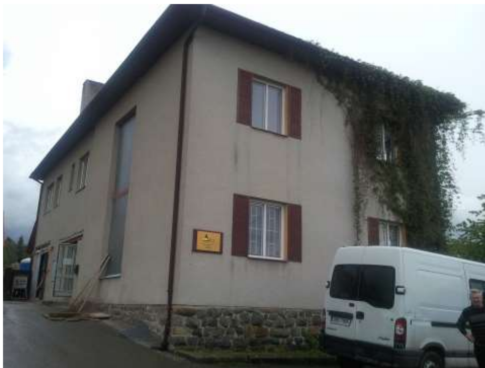
Obrázek č. 2 Budova VLS – Lesní správa Žárovice
