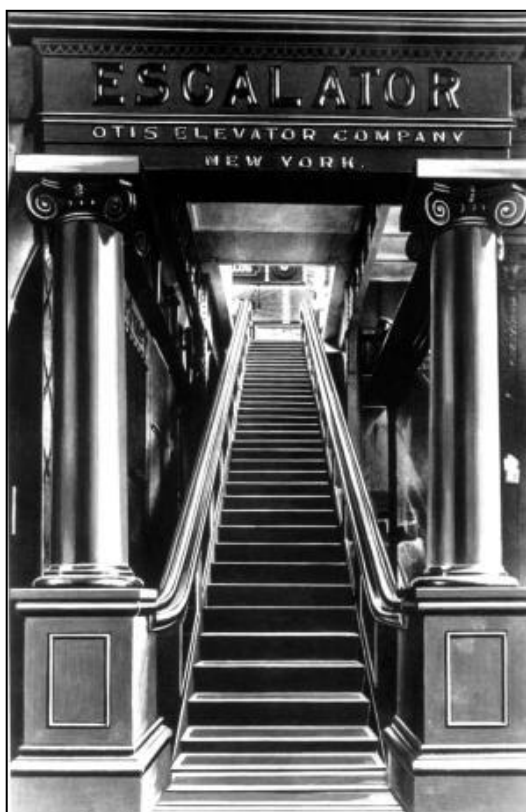
Obr. 3 První eskalátor OTIS představen na světové výstavě v Paříži roku 1900 [22]
