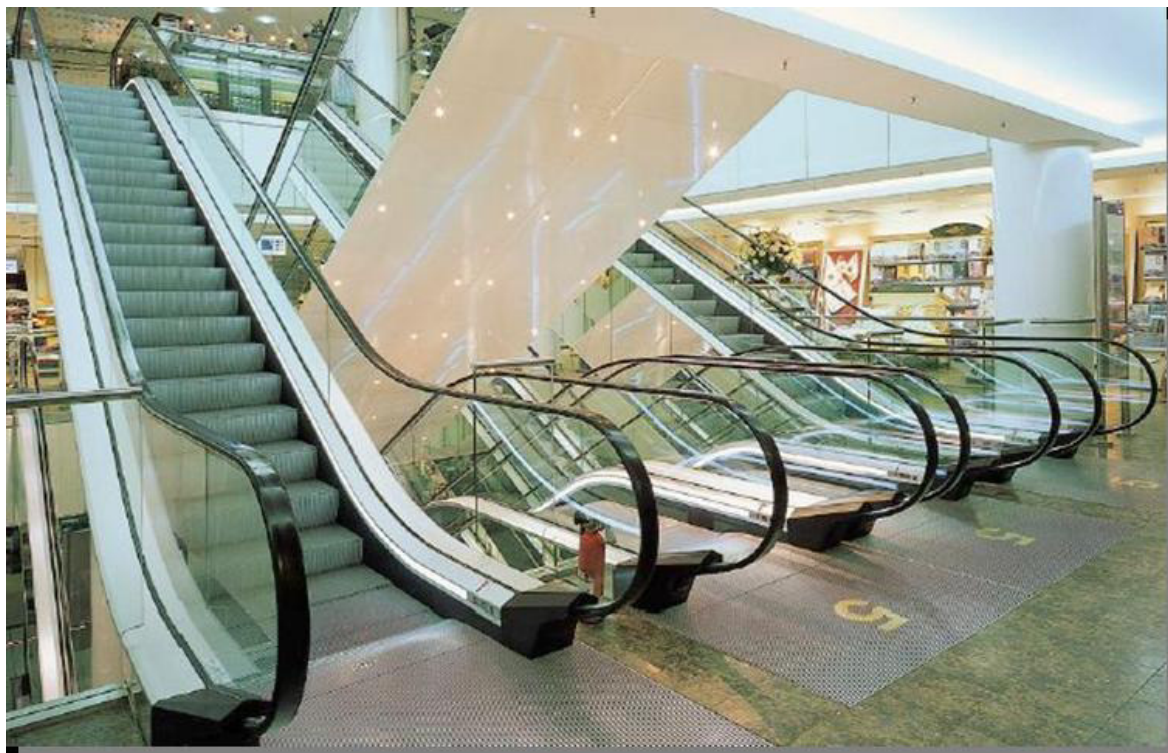
Příloha 1 Eskalátor OTIS 506 NCE [22]
