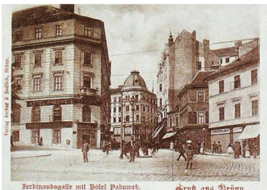
Brno – Hlavní nádraží, ústí Ferdinandovy třídy – 1910
