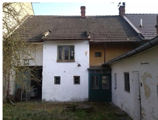
Obr. 2 – Foto, Původní stav, pohled ze dvora
