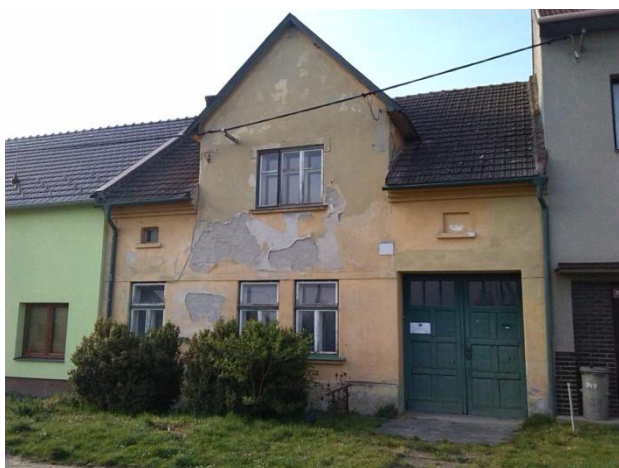
Obr. 1 – Foto, Původní stav, pohled z ulice
