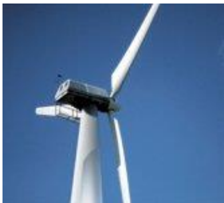
Obr. 26. Aplikace na větrné elektrárně [27]
