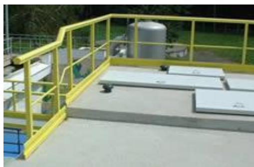
Obr. 28. Aplikace ve vodárně [27]
