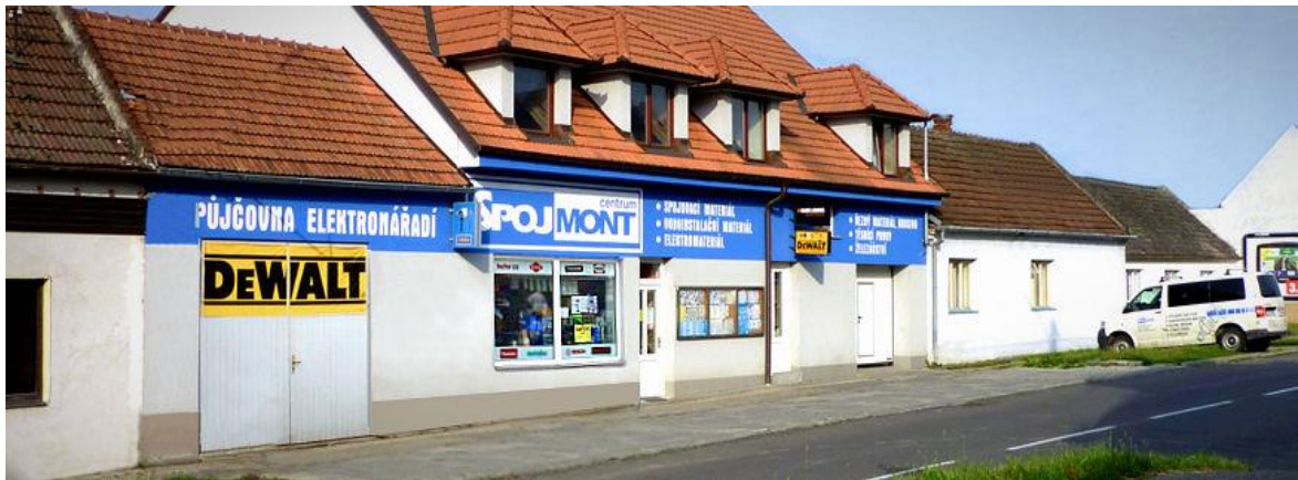
Obrázek 7 Budova společnosti Spojmont centrum (Spojmont.sweb, © 2009)
