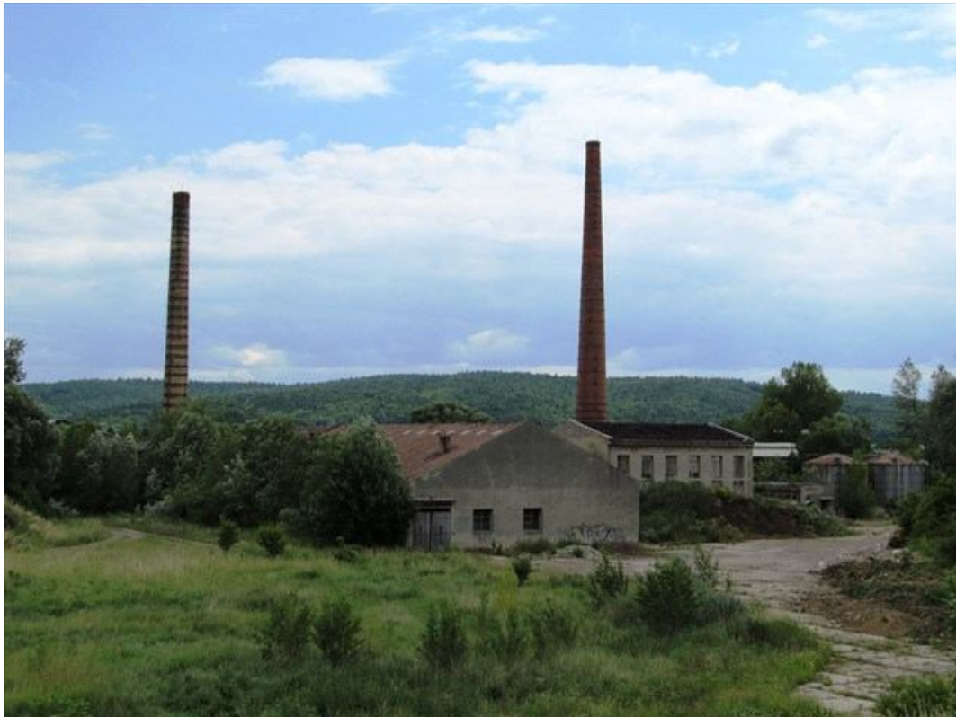
Obrázek 1 Areál bývalé vážanské cihelny (geocaching.com, ©2000-2015)
