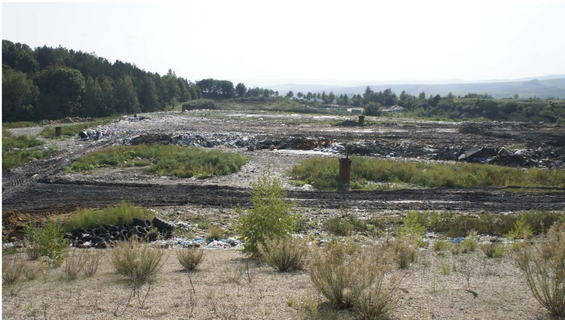
Příloha 8: Skládka Kozlany
