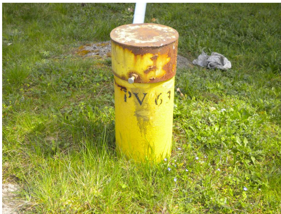
Obrázek 13 Monitorovací vrt u prostoru enkapsulace zemin znečištěných PCB [zdroj vlastní]
