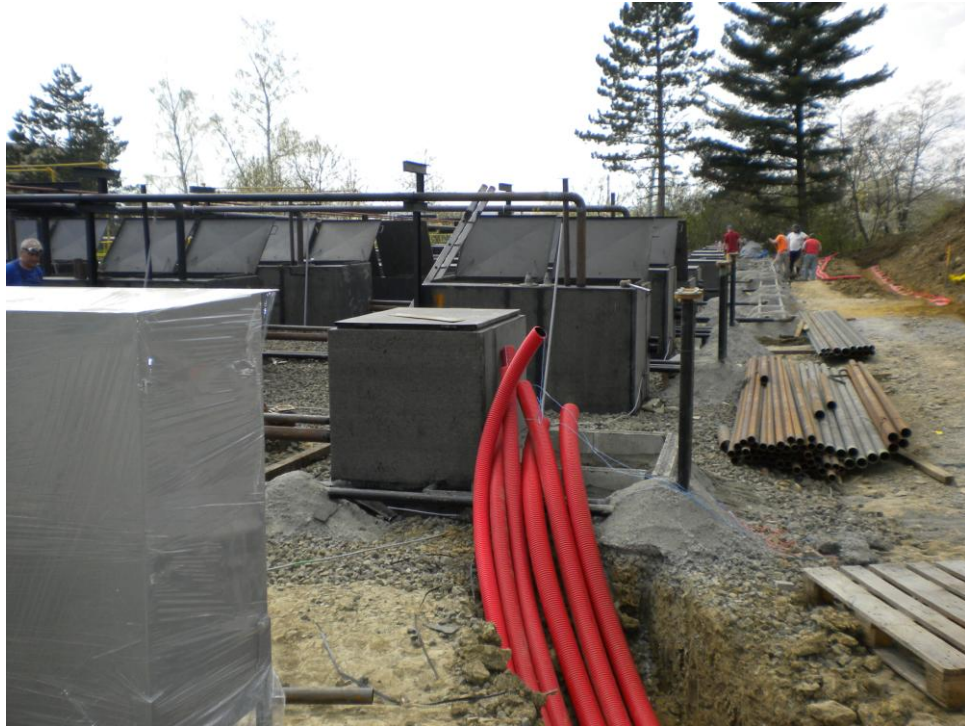
Obrázek 15 Výměna podzemních zásobníků tekutých surovin [zdroj vlastní]
