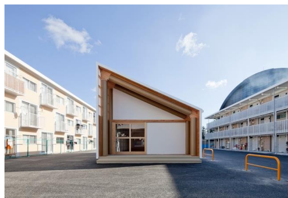
Obrázek č. 23: Post-Tsunami Housing
