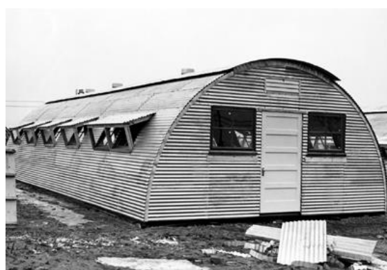
Obrázek č. 6: Quonset Hut
