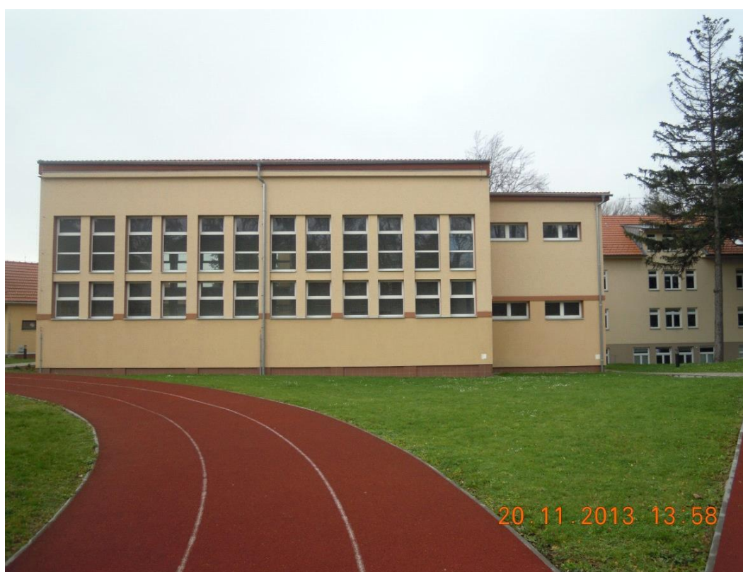
Obr. č. 3 - Tělocvična
